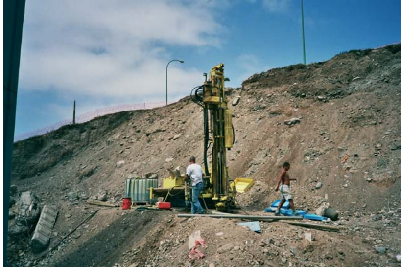
Máquinas de realización de sondeos.
