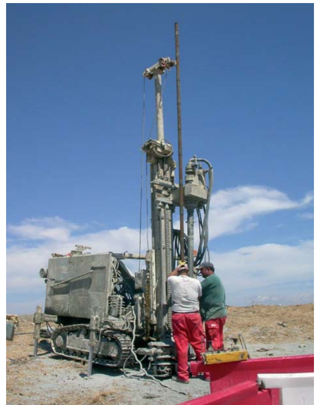
Túnel de Barbate. Sondeo.
